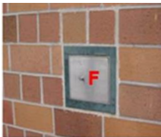
Bild: Feuerwehr-Schlüsseldepot
