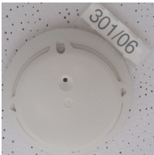
Abbildung 6: Beispiel für Kennzeichnung auch am Melder
